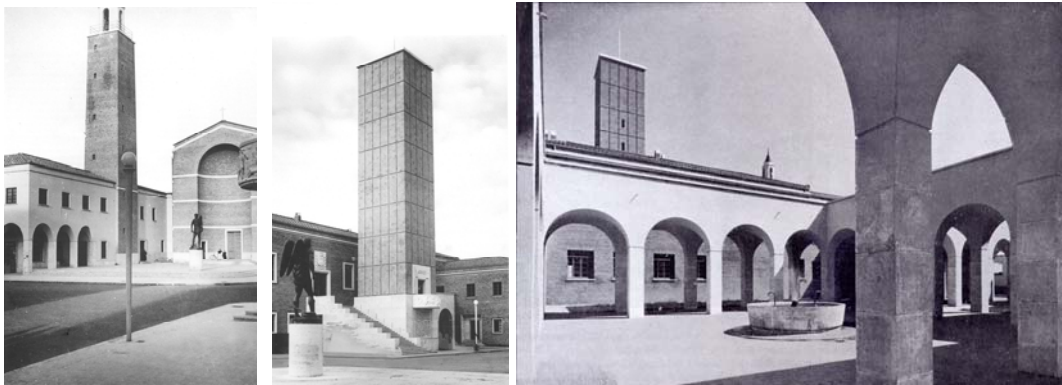
Il campanile, la torre civica, il mercato
