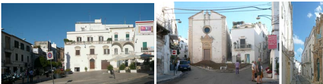
I palazzi settecenteschi sullo sfondo di piazza Sant'Oronzo e la chiesa dello Spirito Santo; sulla destra via Imbriani con uno dei suoi palazzi
